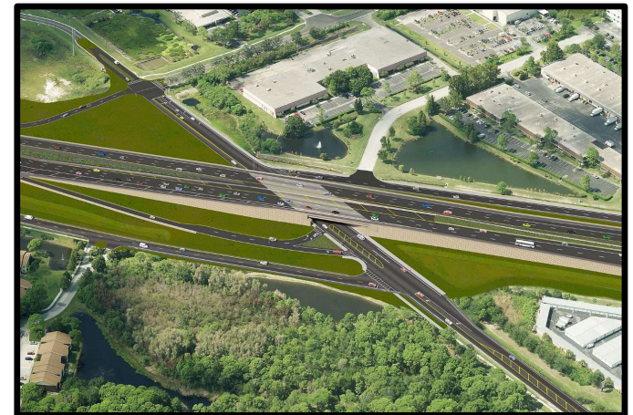
Above: Gandy Blvd (Pinellas)
